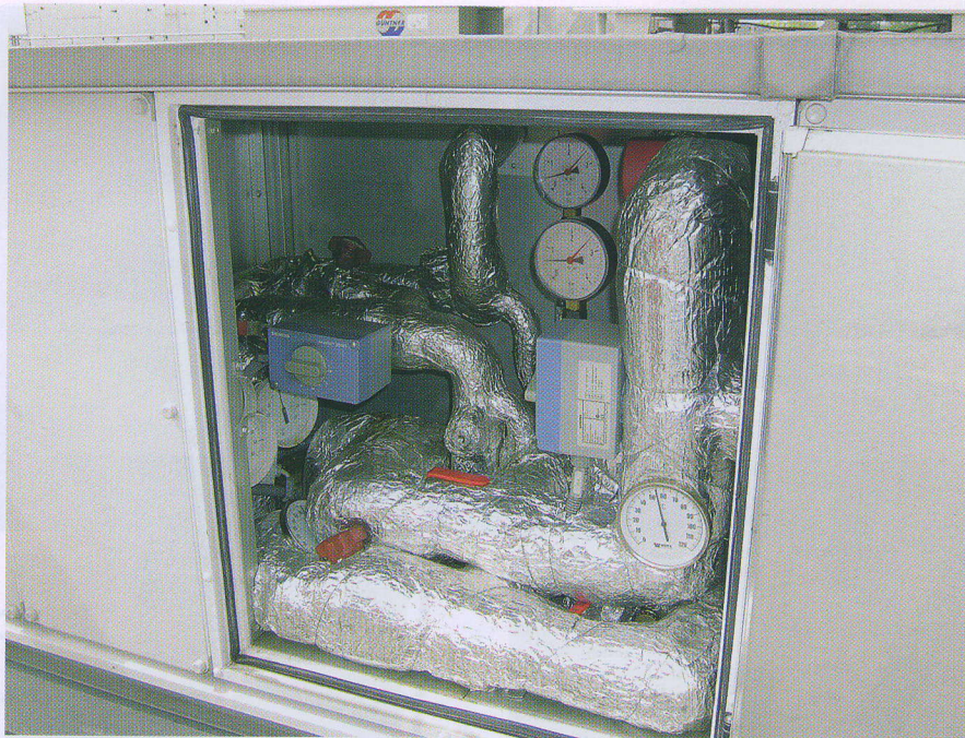
Obr. 4 Nečitateľná indikácia
